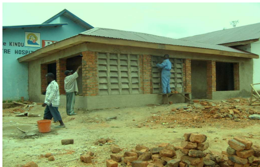
Intonacatura del corridoio
